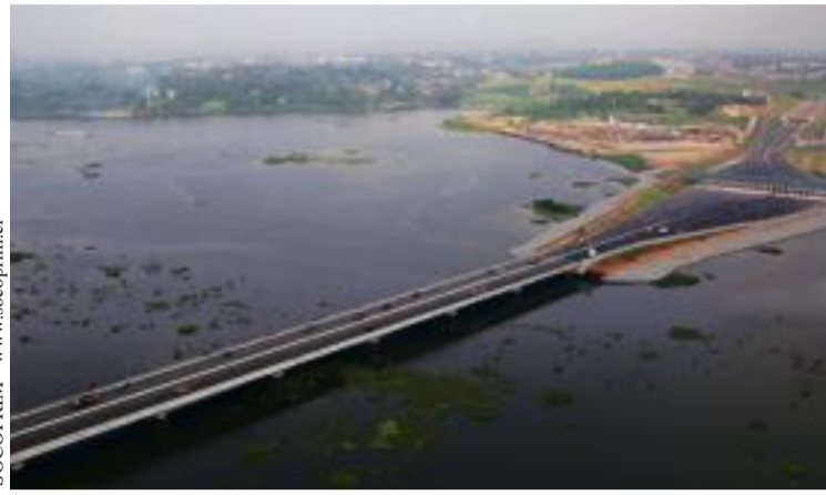
Le Pont Henri Konan Bédié, un défi technique relevé avec brio par la Socoprime, filiale du Groupe Bouygues : les piliers de l'ouvrage sont ancrés dans un sol meuble.
